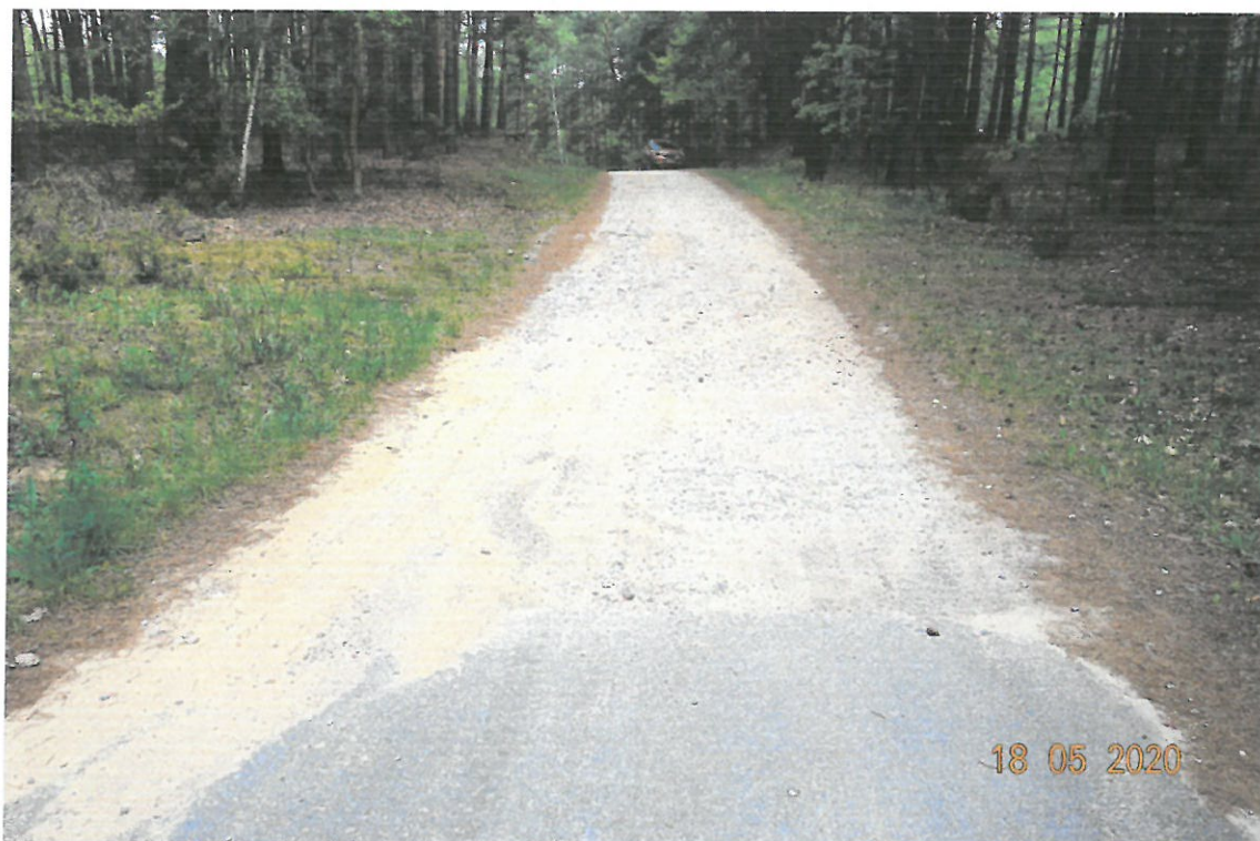
Nr 1. Widok na początek odcinka w kierunku północnym (km 0+000)
