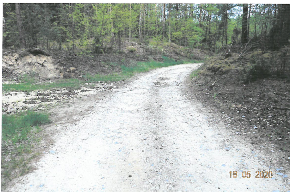
Nr 2. Widok na leśny fragment drogi w km 0+300 (granica działek nr 142 i 54)
